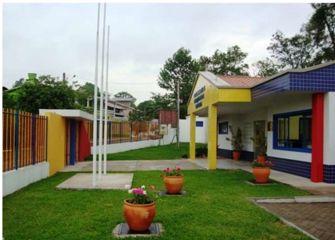
RAMPA DE ACESSO PRINCIPAL
