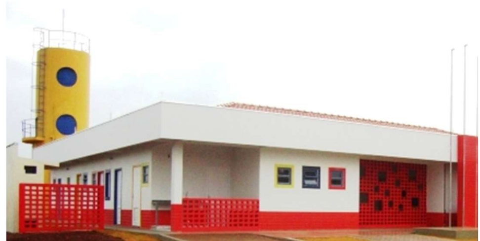
UNIDADES TIPO C CONSTRUIDAS
